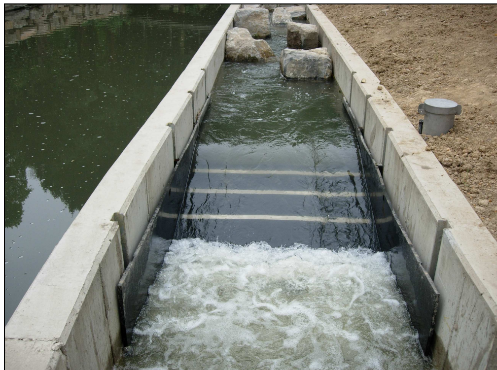
figuur 2.2 In deze afbeelding is goed te zien dat de waterstroming over de meetstuw niet laminair is.
