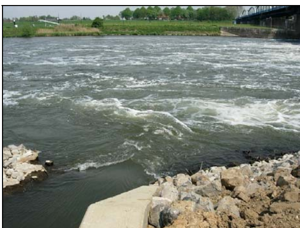
Figuur 2.1 De uitstroom van de vistrap in de Maas benedenstrooms van de stuw
