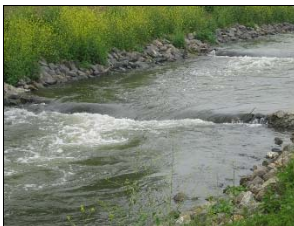
Figuur 2.1 Overlaat opgebouwd uit schanskorven.
