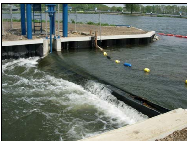
Figuur 2.1 De regelbare overlaat aan de bovenstroomse zijde van de vispassage
